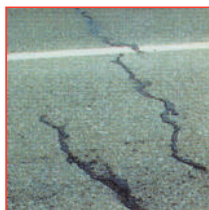
1. La réfection des fissures pages 3 – 5
