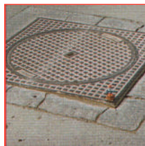
6. La réfection autour des regards pages 14 – 15
